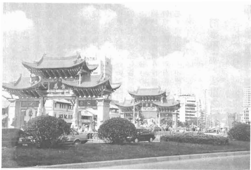
昆明新建三牌坊
