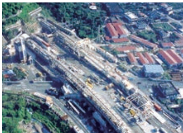
兩部主隧道 TBM 在洞口組裝的壯觀情況
