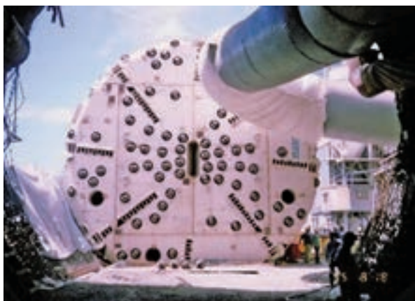
TBM 組裝完成推進至洞口準備進洞開挖
